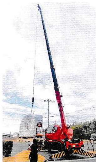
新CT搬入設置
